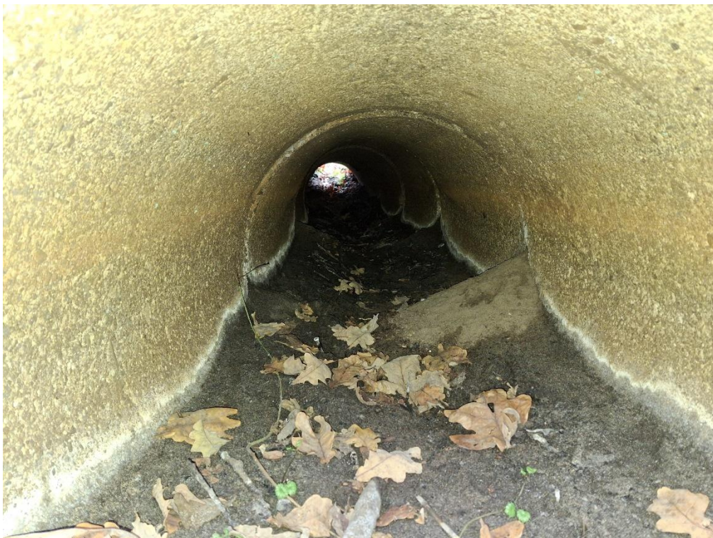
Fot. 7. Zamulony przepust do przebudowy
