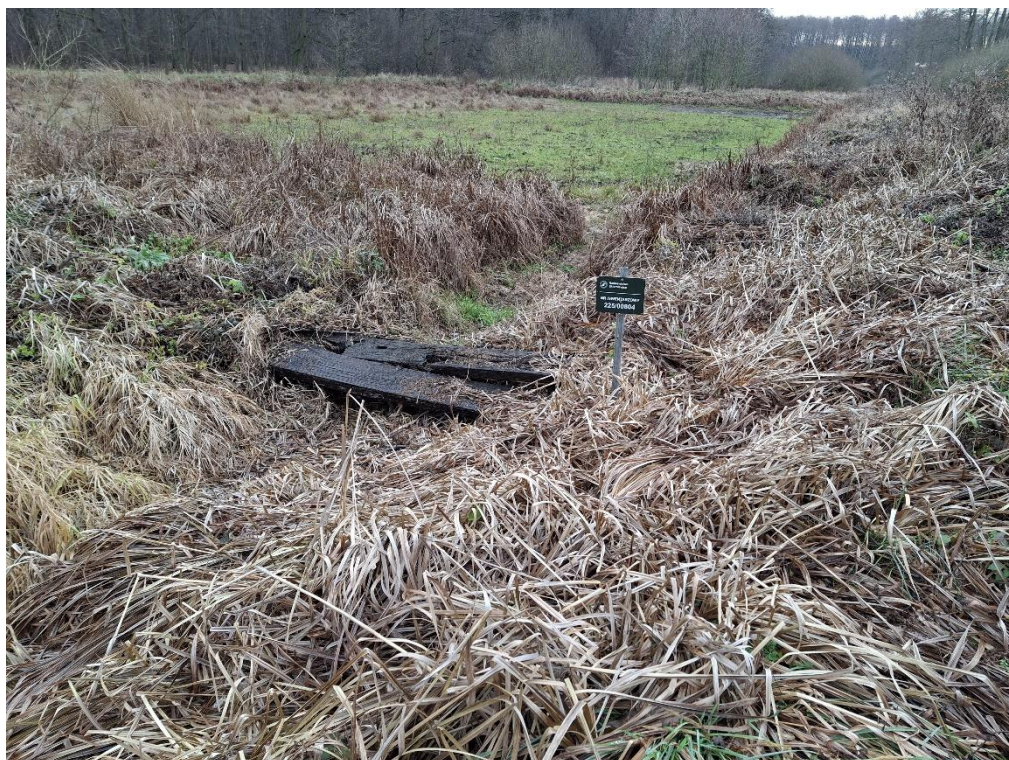
Fot. 23. Zastawka piętrząca
