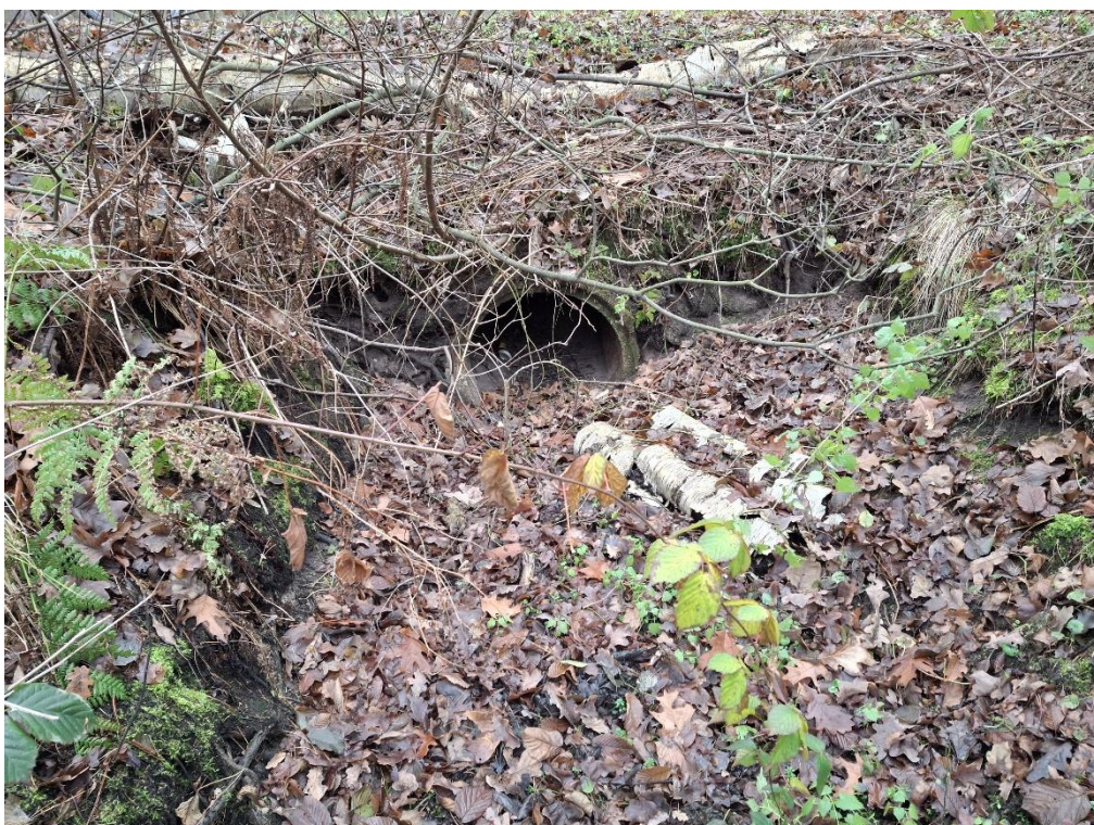
Fot. 20. Przepust na rowie odpływowym (lokalizacja nowego przepustu z piętrzeniem)
